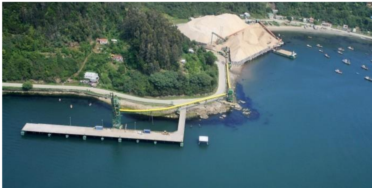
Ilustración 73: Vista general del frente de atraque muelle Puerto Corral
